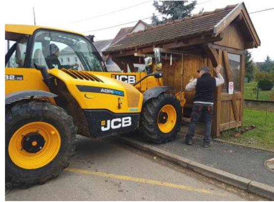
Afin de sécuriser et d'apporter plus de confort aux utilisateurs des transports en commun, les élus et l'agent communal se sont relevé les manches pour aménager un espace pavé à l'abribus. Il a fallu décaisser, remblayer, damer et poser les pavés dans les règles de l'art.
